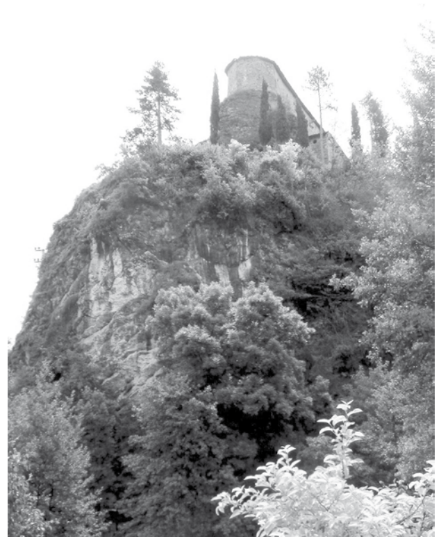
La parete Nord-Ovest della Rocca.
